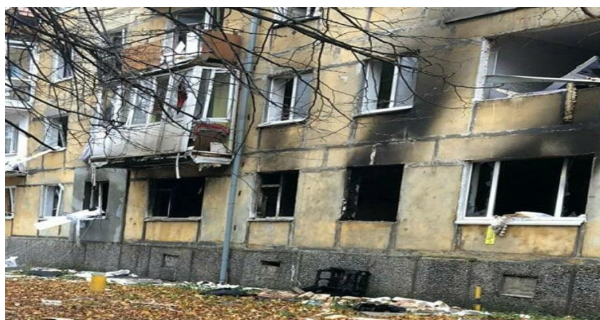
Рис. 2. Последствия взрыва газа в жилом многоквартирном доме в г. Балтийск 26.10.2021 г.
