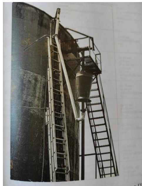
Рис 7. Модуль телескопической мачты для вырезания отверстия и подачи пены
