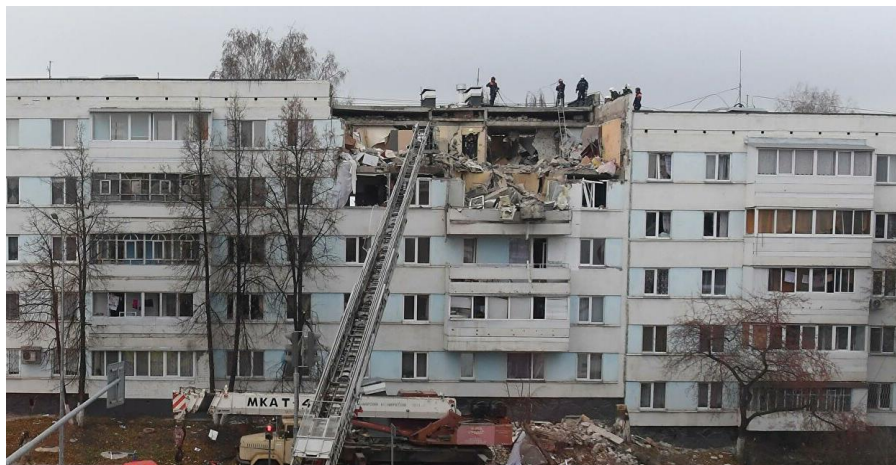
Рис. 1. Последствия взрыва газа в жилом многоквартирном доме в г. Набережные Челны 25.10.2021 г.
